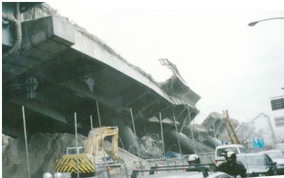
兵庫県南部地震時の高速道路の倒壊 写真：高橋良和
