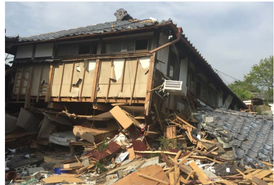
熊本地震の木造建築の被害 写真：和田 章
