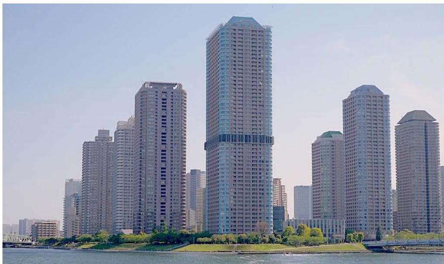
沿岸に建設される超高層ビル（東京都大川端地区）
