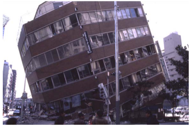
兵庫県南部地震で倒壊した建物
