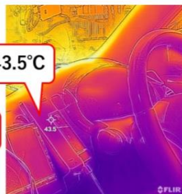
図. エアコン吹出口
