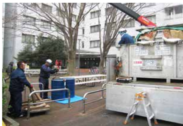
写真 1 PCB 廃棄物を処分場へ運び出す様子
