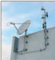
本館屋上の衛星通信システム用 パラボラアンテナと無線LAN アクセスポイント
