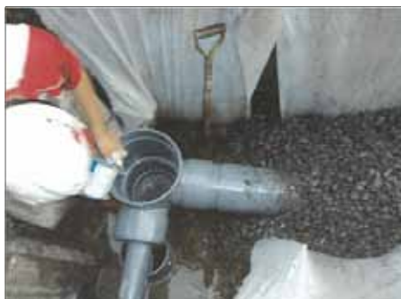
西2号館改修工事での雨水浸透施設 穴の空いた浸透枺や浸透管により地中に雨水を還元します。
