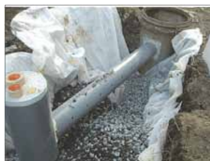
西2号館改修工事での雨水浸透施設 穴の空いた浸透枺や浸透管により地中に雨水を還元します。
