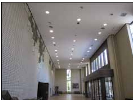
講堂ロビー耐震天井とLED照明
