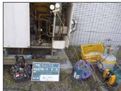
エアコンからのフロンガス回収
