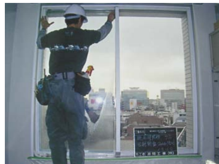
(建物の窓ガラス省エネフィルム張り)
