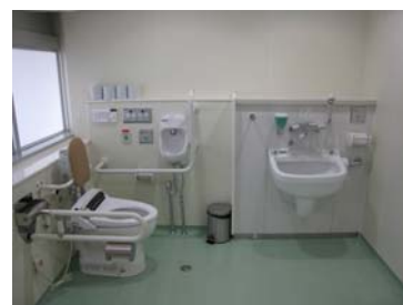
P棟改修（多目的トイレ）
