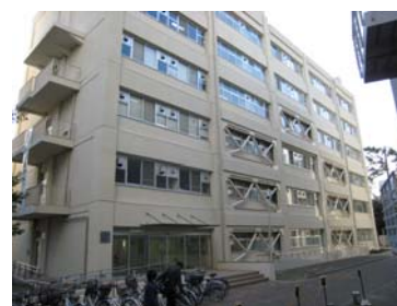
P棟改修（耐震補強）
