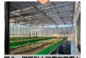
図3 円筒形太陽電池発電と植物育成を両立する実証実験
