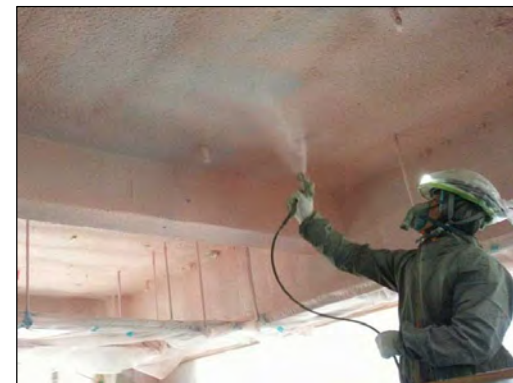
【外部に面する天井への断熱材吹付】
