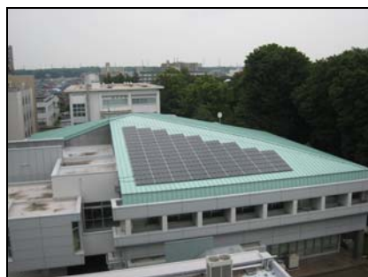
太陽光発電設備
